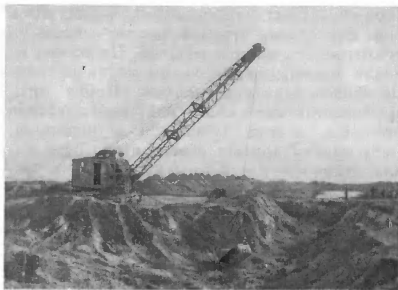
На западном участке строительства Кара-Кумского канала. Июнь, 1954 г.
